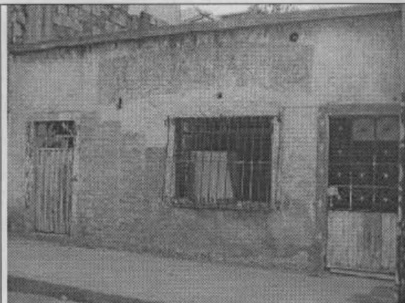
Foto 1. Vista general del muro.
