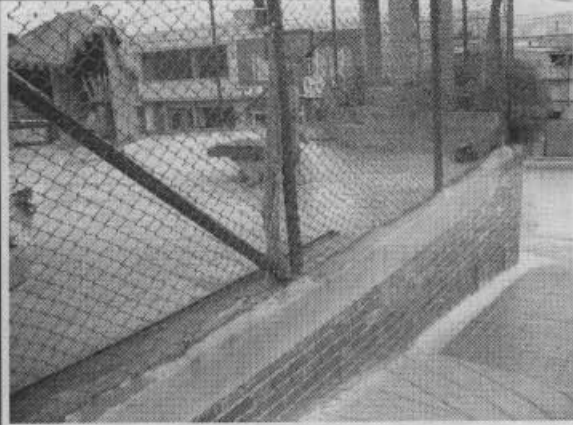
Foto 2. Relleno para conformar el lote de terreno
