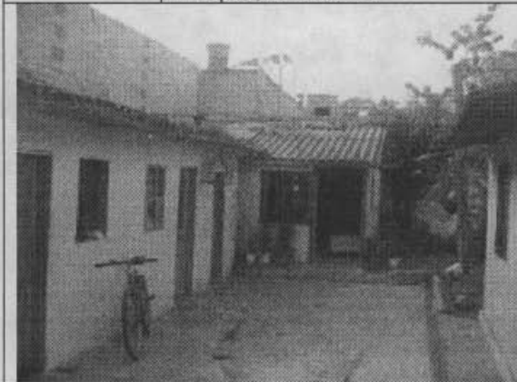
Foto 9. Edificaciones D, E y F
