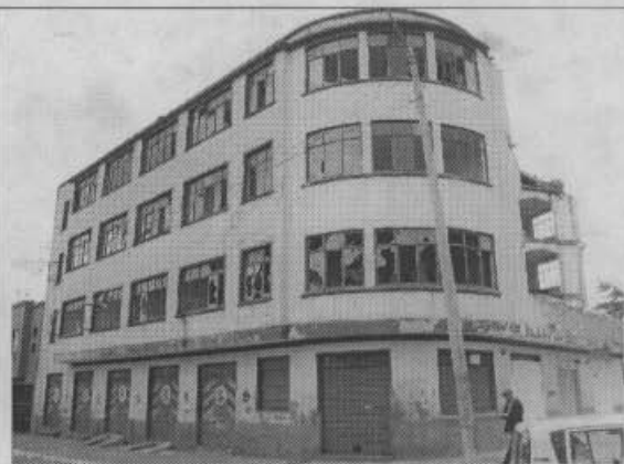
Foto 2. Vista general sobre la calle 22 C.
