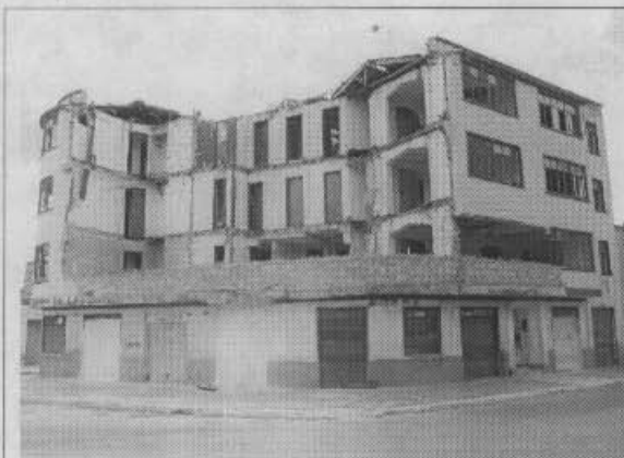
Foto 1. Vista general del inmueble inspeccionado de nomenclatura diagonal 22 C No. 19-07.
