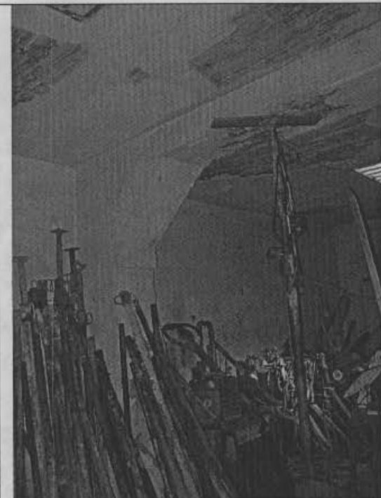
Foto 3. Paral metálico como apoyo provisional a una de las vigas.
