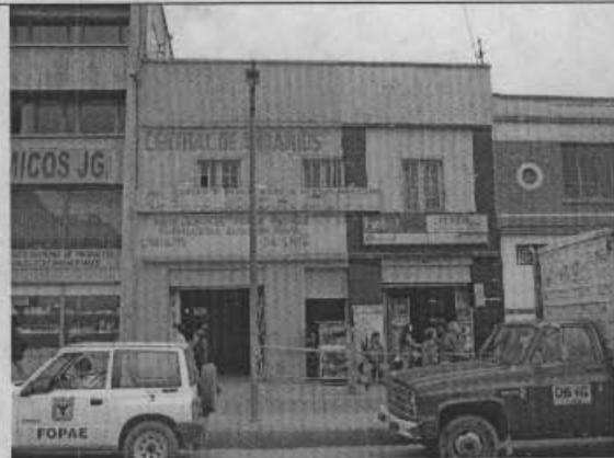
Foto 1. Vista general del inmueble inspeccionado de nomenclatura calle 30 No. 5-19/21.
