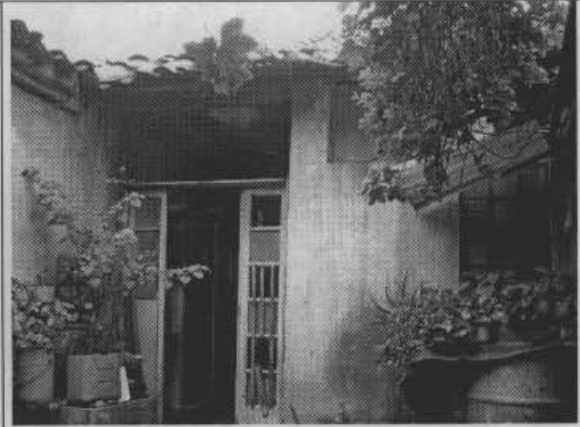
Foto 2. Vista del patio interior.
