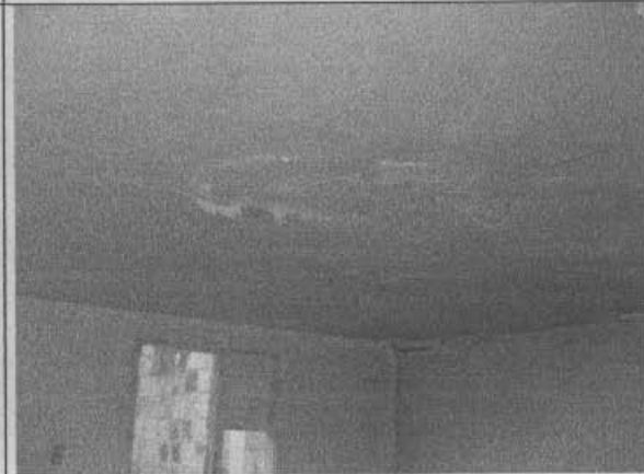
Foto 4. Placa fisurada.
