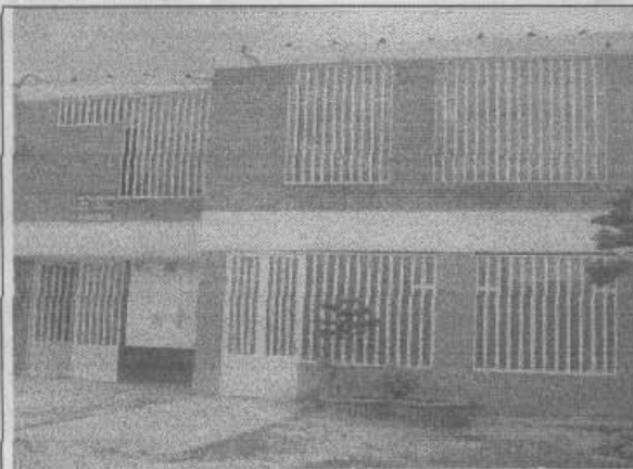
Foto 1. Fachada de la edificación al momento de la visita.
