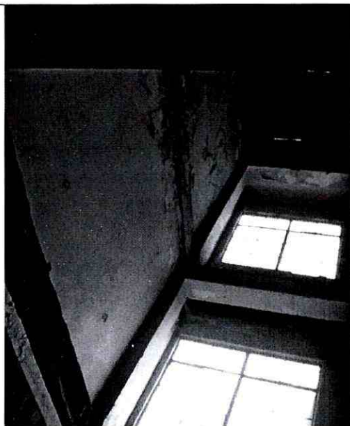
Foto 5. Vista interior falta total de los entre pisos.
