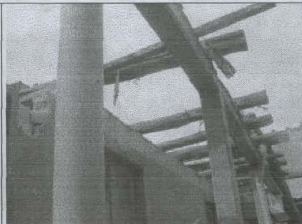
Foto 2. Muros de segundo piso (actualmente en demolición).
