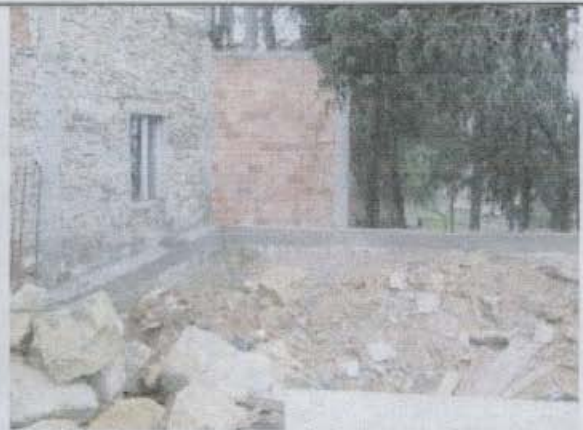
Foto 2. Muro en mampostería confinada con relleno de escombros
