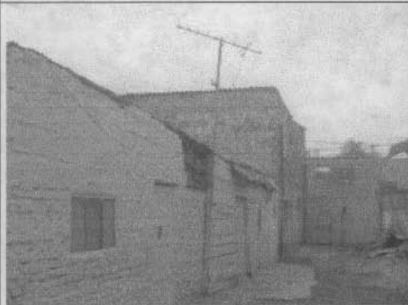
Foto 3. Edificación de un piso en mampostería con teja de zinc
