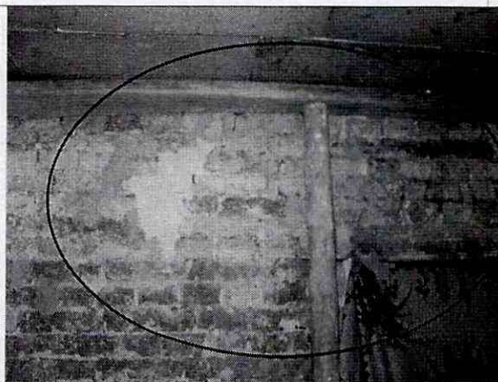
Foto 3. Apuntalamiento temporal contra el muro de culata occidental. Desplazamiento evidente hacia ladera.
