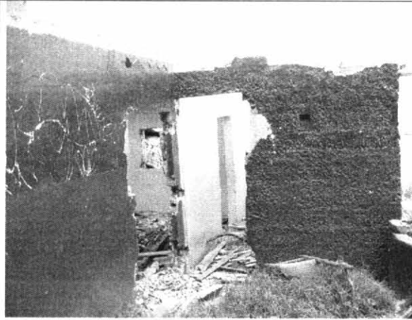
Foto 1. Fachada de la edificación al momento de la visita
