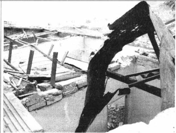
Foto 2. Desmonte total de la cubierta
