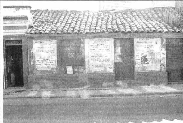
Foto 1. Condiciones generales del exterior del inmueble al momento de la visita.
