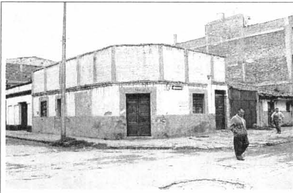
Foto 1. Condiciones de fachada al momento de la visita.
