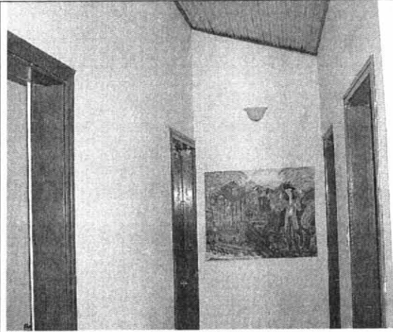
Foto 4. Corredor de segundo piso, sin afectaciones estructurales apreciables.
