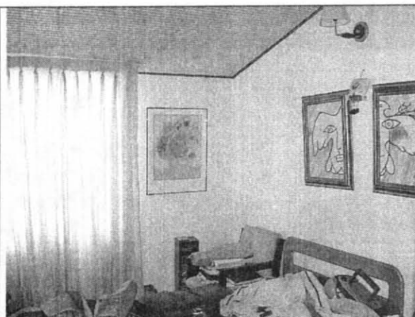
Foto 2. Estado actual al interior del inmueble
