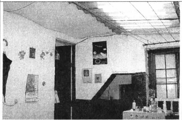
Foto 4. Al interior del inmueble no se evidencian daños que indiquen mal comportamiento estructural.
