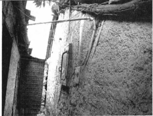
Foto 2. Muro lateral de la construcción principal.
