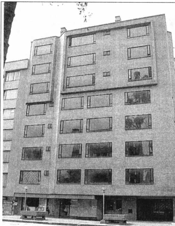
Foto 1. Fachada de la edificación en las condiciones presentes al momento de la visita.
