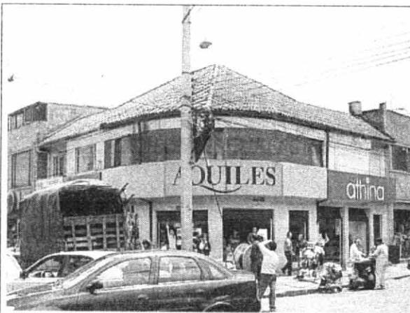
Foto 1. Condiciones de fachada al momento de la visita.
