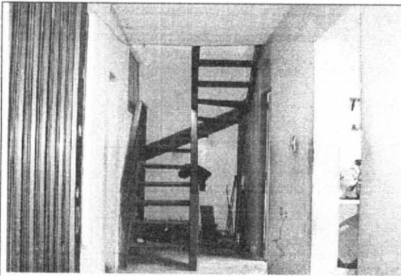
Foto 5. Interior del inmueble sin afectaciones apreciables que evidencien mal comportamiento estructural.
