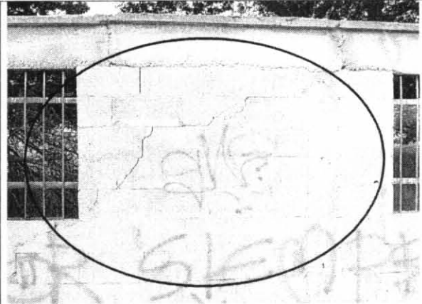
Foto 6. Algunas de estas grietas diagonales atraviesan las unidades de mampostería.
