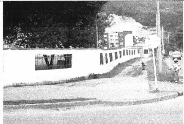
Foto 2. Aspecto general del muro objeto del concepto visto por el costado sur.
