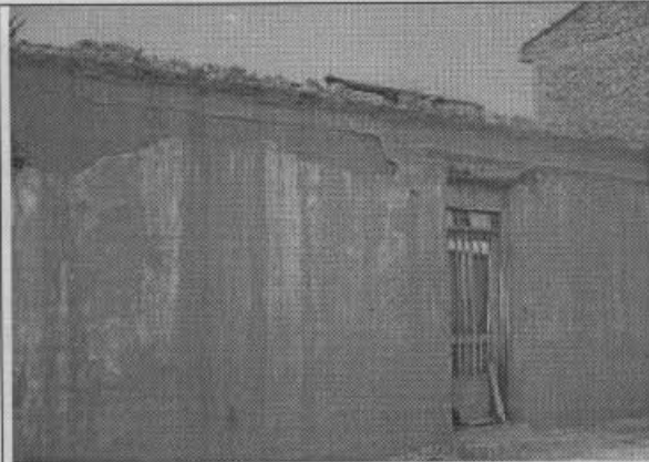
Foto 1. Fachada en el momento de la visita.
