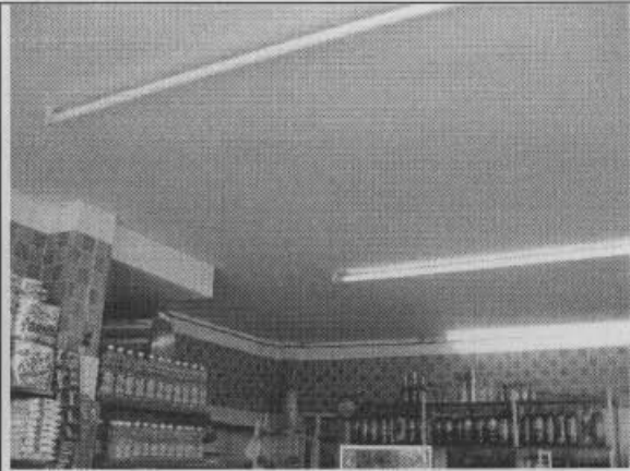
Foto 2. Aspecto interno de la edificación en primer piso
