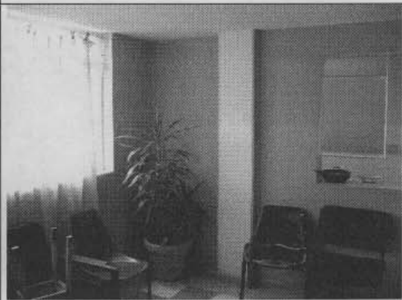
Foto 4. Los elementos estructurales no presentan daños
