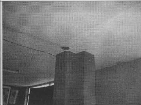
Foto 6. Nudo placa-columna sin afectaciones visibles
