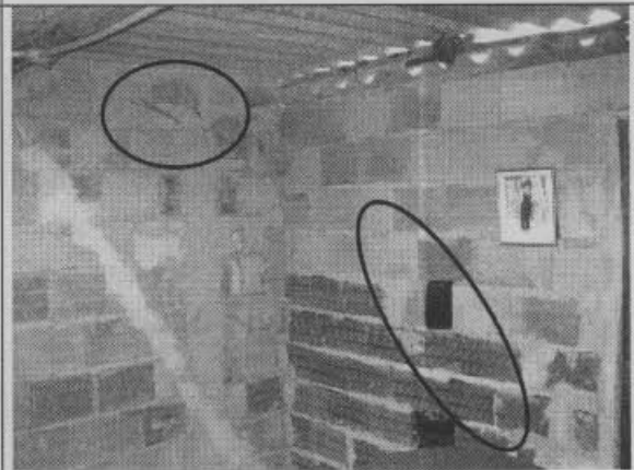
Foto 6. Puntos con falta de pega y prolongación de aceros
