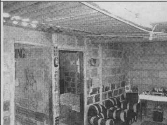
Foto 5. Muros internos de segundo piso, sin daño aparente
