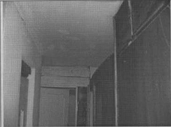
Foto 4. Placa y muros interiores.
