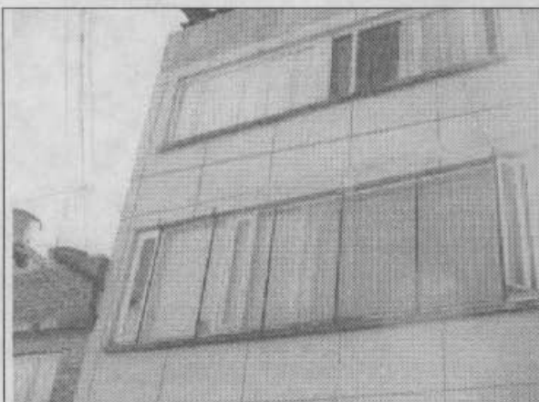
Foto 1. Vista general del inmueble.
