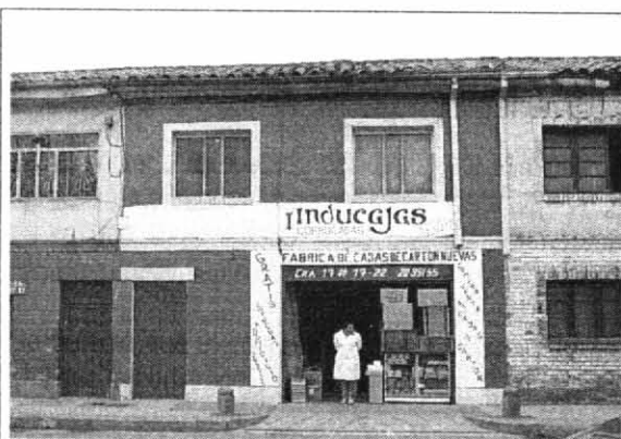
Foto 1. Fachada de la edificación en las condiciones presentes al momento de la visita.
