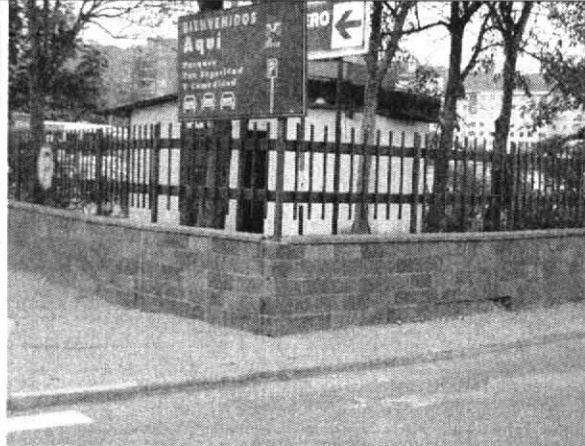
Foto 1. Aspecto general del muro objeto de la visita.
