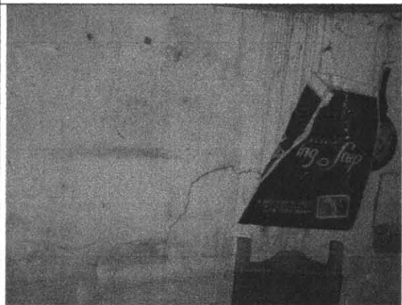
Foto 5. Muros fisurados.
