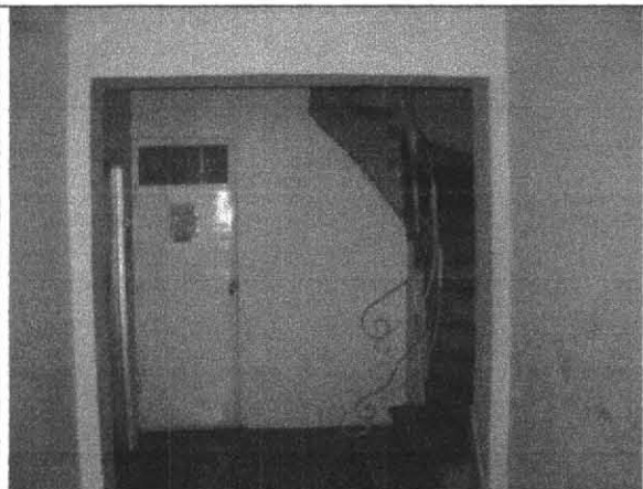
Foto 3. Fachada interior costado Norte.
