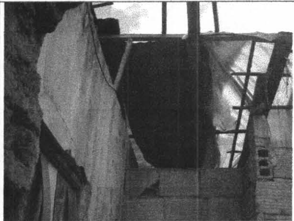
Foto 6. Cubierta en regular estado
