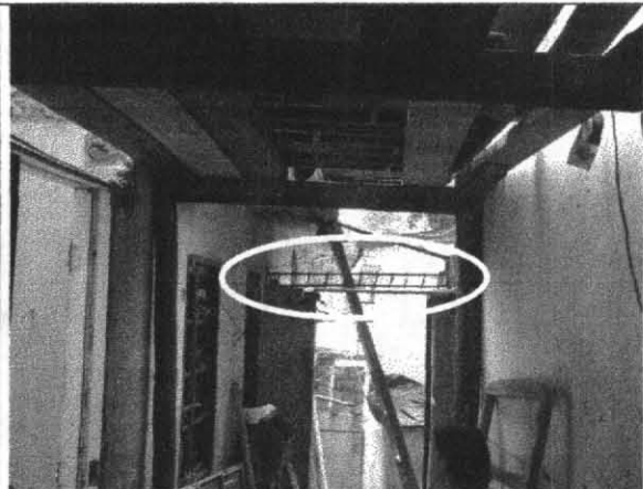
Foto 3. Interior de la edificación y obra en construcción.
