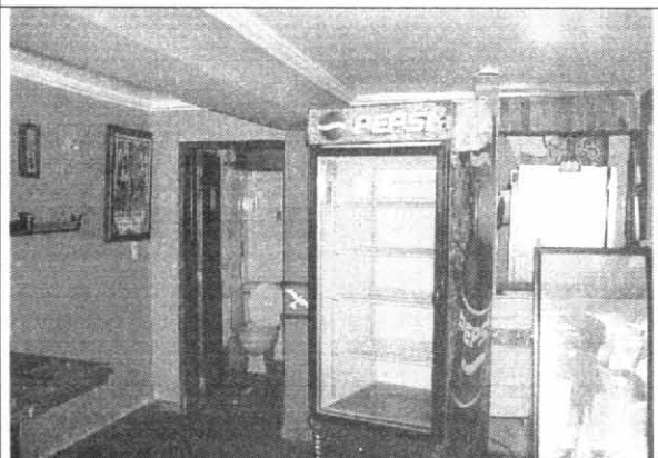
Foto 10. Vista general por el interior del inmueble, sin afectaciones estructurales que indiquen riesgo de colapso inminente.
