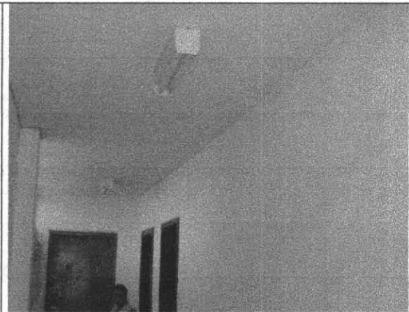
Foto 6. Interior del edificio en buen estado.
