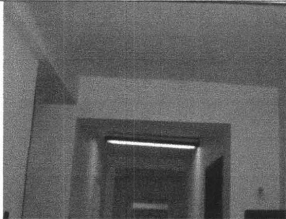
Foto 7. Interior del edificio en buen estado.
