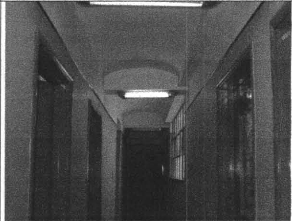
Foto 8. Interior del edificio en buen estado.
