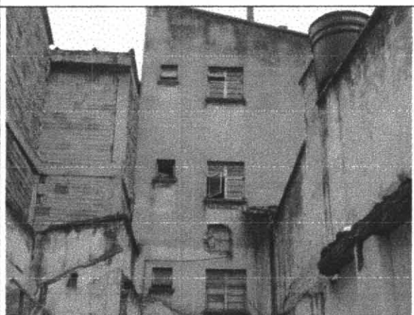
Foto 3. Fachada interior costado Norte.
