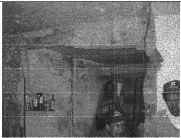
Foto 12. Modificaciones muros apartamento en piso 3.
