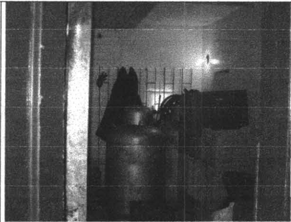
Foto 8. Tanques de gas en Piso 2.
