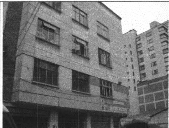
Foto 1. Fachada por la Carrera 4.
