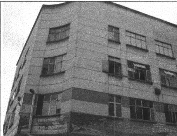
Foto 2. Fachada por la calle 20.
