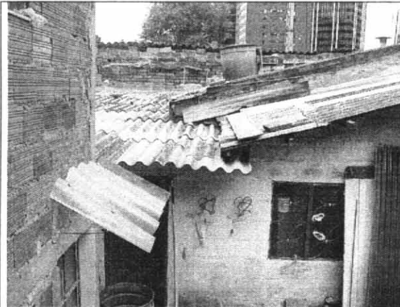
Foto 5. Construcción de un (1) piso ubicada en la parte posterior del predio.
