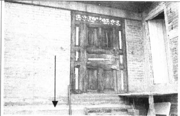
Foto 2. Muro fachada visto por el interior del inmueble, estructura de contención bajo la rasante de la carrera 5.
