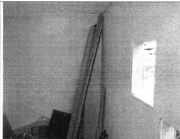
Foto 7. Muros interiores sin daño estructural aparente.
