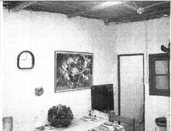
Foto 6. No se identifican daños en los muros interiores que evidencien mal comportamiento estructural.
