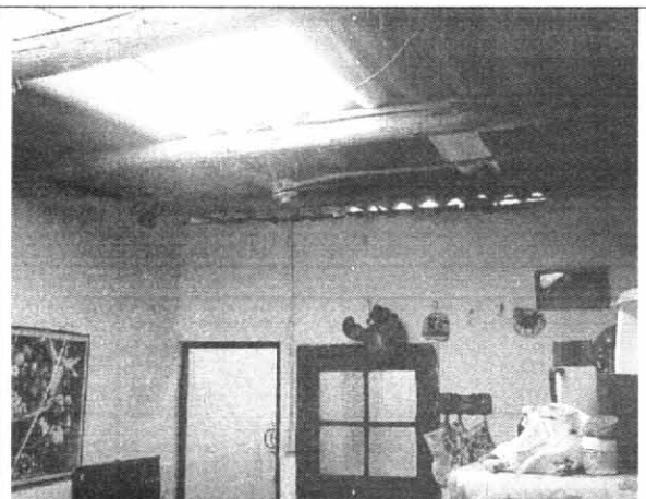
Foto 8. La estructura de cubierta esta en buen estado.
