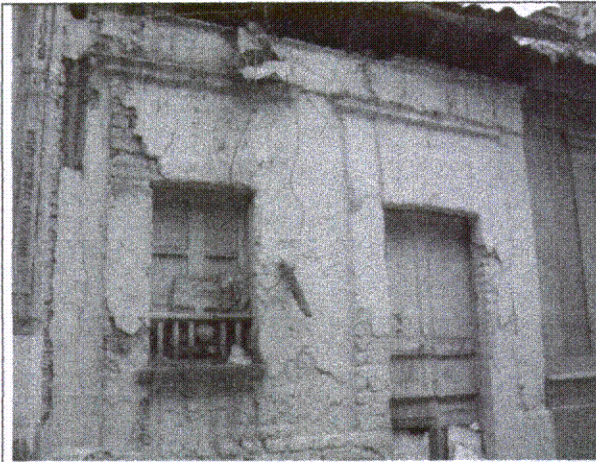
Foto 1. Fachada del predio.
