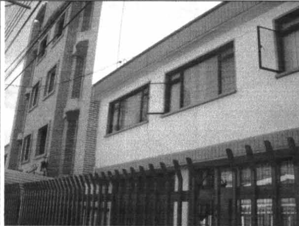
Foto 1. Fachada del predio.
