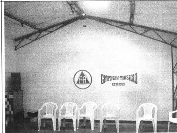
Foto 4. Vista interior del inmueble, sin daños estructurales apreciables. Sala de reuniones.
