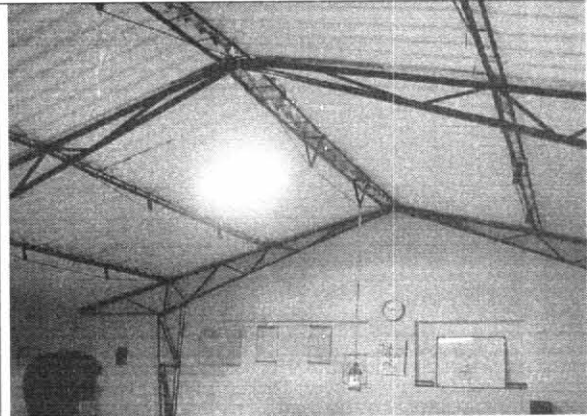
Foto 6. Vista de cubierta, sin daños que evidencien mal comportamiento estructural.
