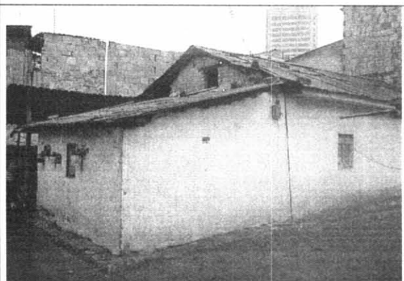
Foto 4. Construcción de un piso ubicada en el interior 1, costado sur.
