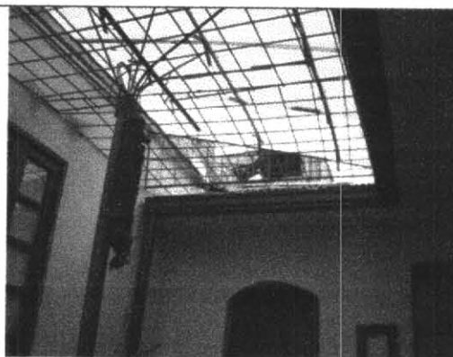
Foto 4. Patio interior que colinda con la edificación localizada en la Calle. 13 A # 1-25.
