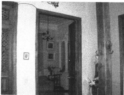
Foto 3. Estructura en buen estado.
