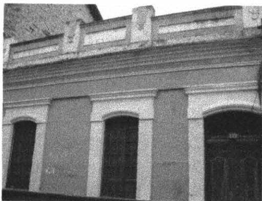
Foto 1. Fachada de la edificación.
