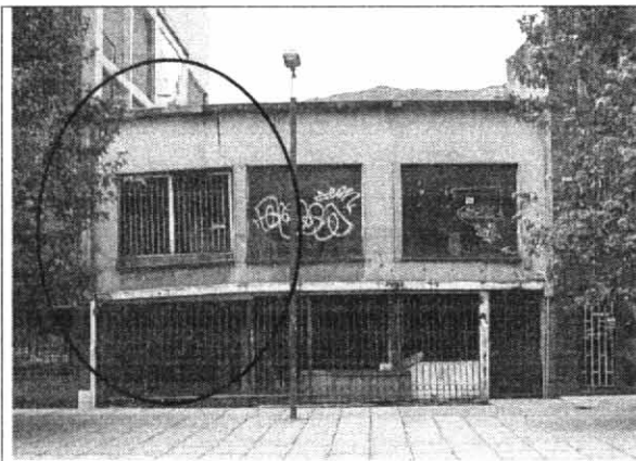
Foto 1. Condiciones de fachada al momento de la visita.
