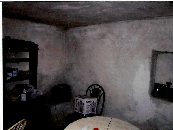
Foto 3. Muros internos del sótano sin evidencia de daño.
