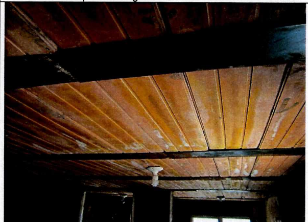
Foto 16. Cara inferior de la placa de cubierta sin acabados.
