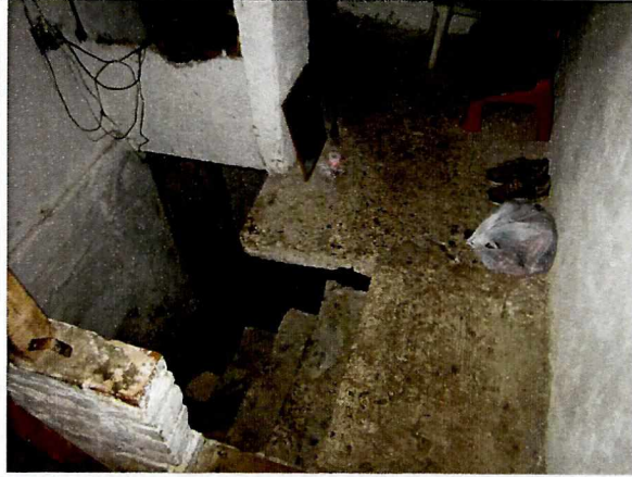
Foto 13. Placa de primer piso cara superior en buen estado.
