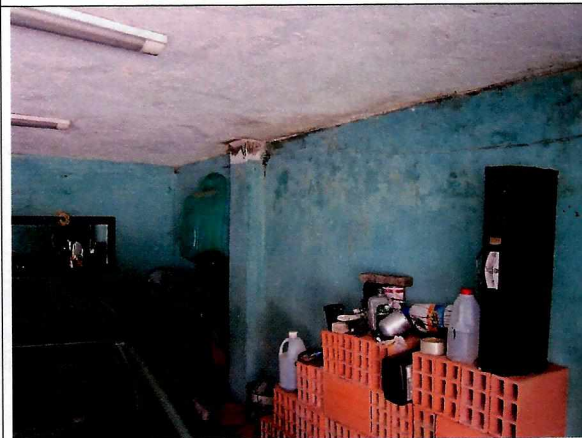
Foto 5. Muros y columna en primer piso, sin daño visible.
