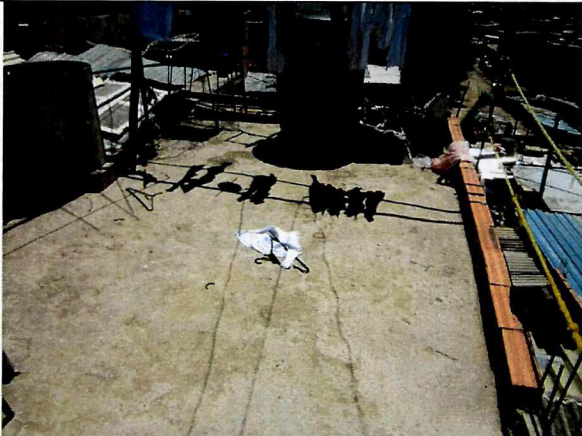
Foto 17. Placa de cubierta en buen estado, daño leve.
