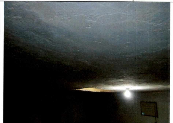
Foto 12. Placa aérea de primer nivel sin daño estructural.
