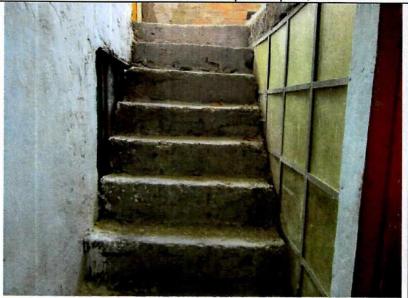
Foto 21. Escaleras de segundo a tercer piso sin acabados.
