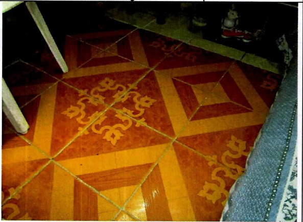
Foto 23. Placa de piso en sótano sin evidencia de daño.
