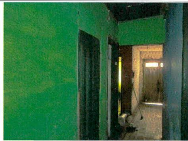
Foto 14. No se evidencia daño estructural al interior
