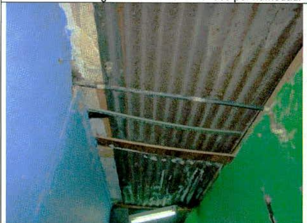
Foto 23. Lámina metálica en sector central, sin daño.
