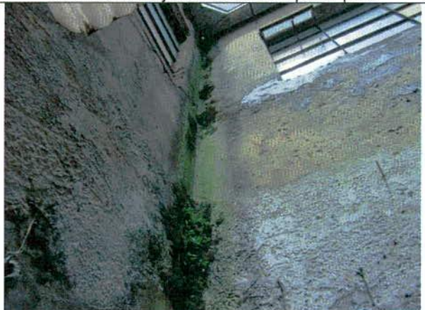
Foto 17. Deterioro de los acabados de fachadas internas.
