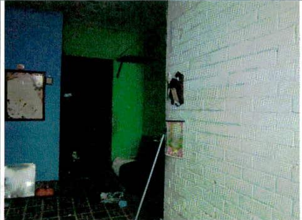
Foto 2. Muros internos de primer piso.
