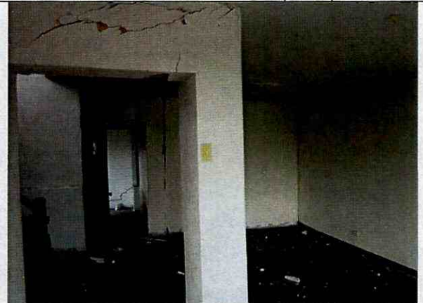
Foto 12. Aspecto interno del segundo piso.
