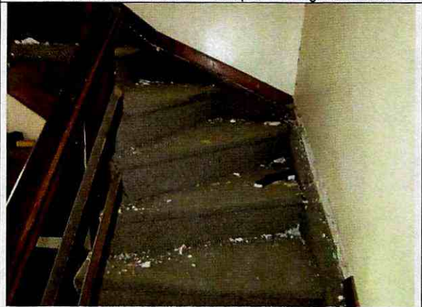
Foto 23. Escaleras de madera sin daño visible.
