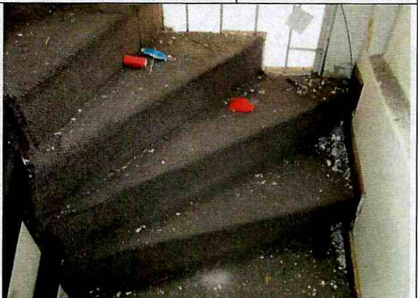
Foto 24. Escaleras de concreto sin evidencia de daño.
