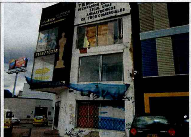
Foto 2. Fachada del costado norte.
