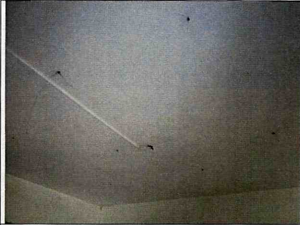
Foto 21. Cara inferior del entrepiso de segundo nivel.
