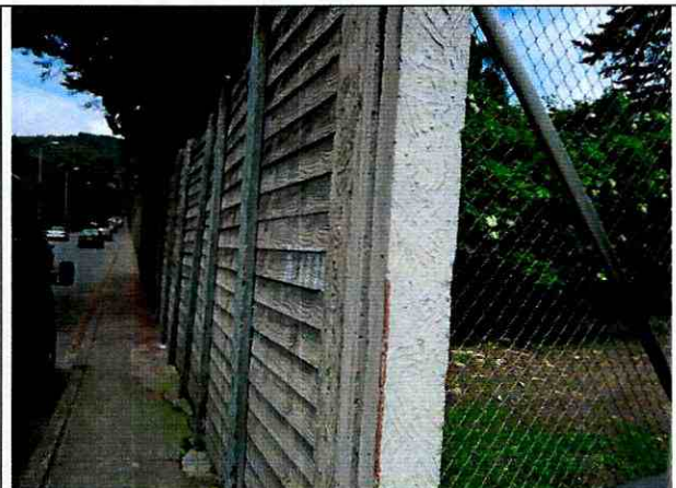
Foto 2. Extremo occidental del cerramiento en concreto.
