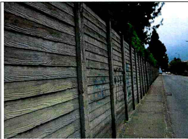
Foto 1. Cerramiento costado norte del predio.
