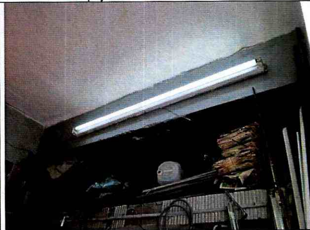
Foto 18. Viga de entrepiso en el local comercial.
