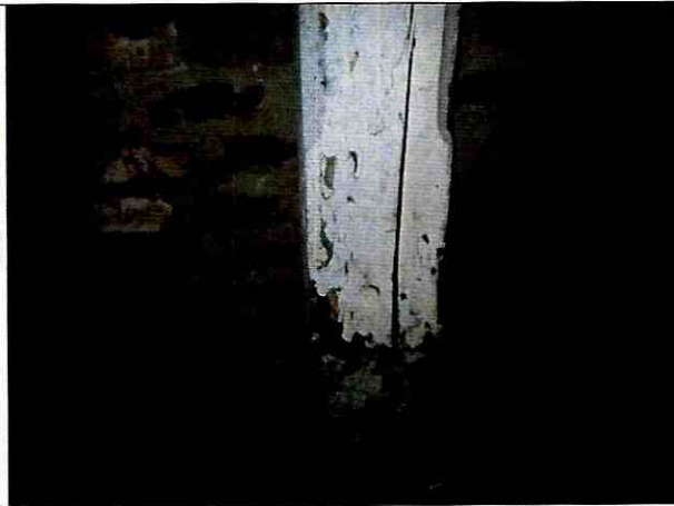
Foto 16. Apoyo de columna de madera, deterioro.
