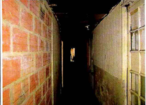
Foto 4. Muros de primer piso con modificaciones.
