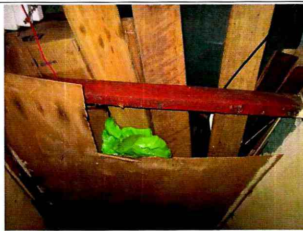
Foto 28. Cielo raso en láminas de madera.
