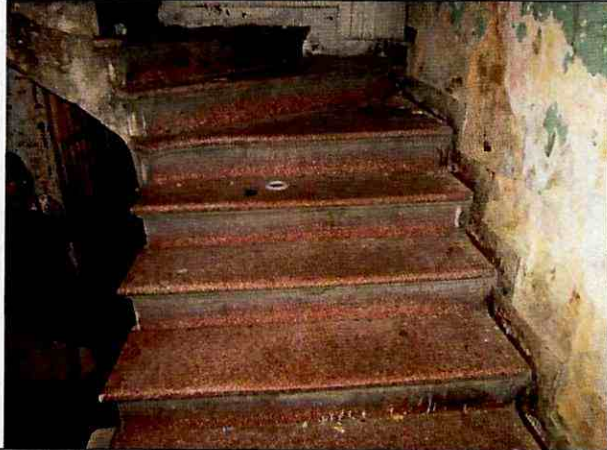
Foto 23. Escaleras a segundo nivel sin evidencia de daño.
