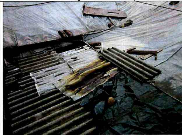
Foto 31. Sectores de la cubierta en fibrocemento.
