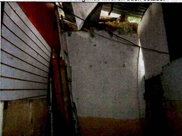
Foto 13. Muros del segundo piso sector posterior.
