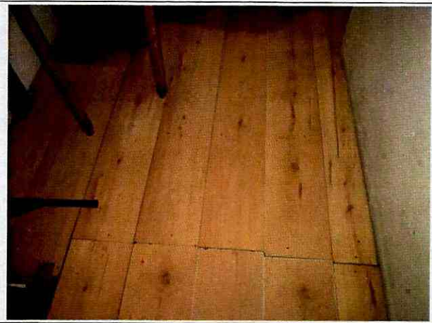
Foto 22. Entrepiso del mezzanine sin daño.
