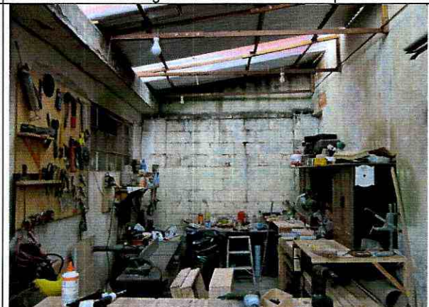
Foto 12. Sector patio cubierto posterior, costado sur.
