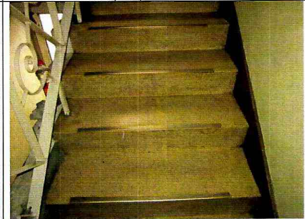
Foto 32. Escaleras en buen estado estructural.
