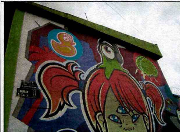
Foto 3. Muro culata del costado occidental.
