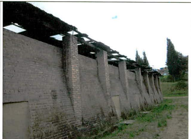
Foto 24. Muro lateral del horno 2, machones de mampostería.
