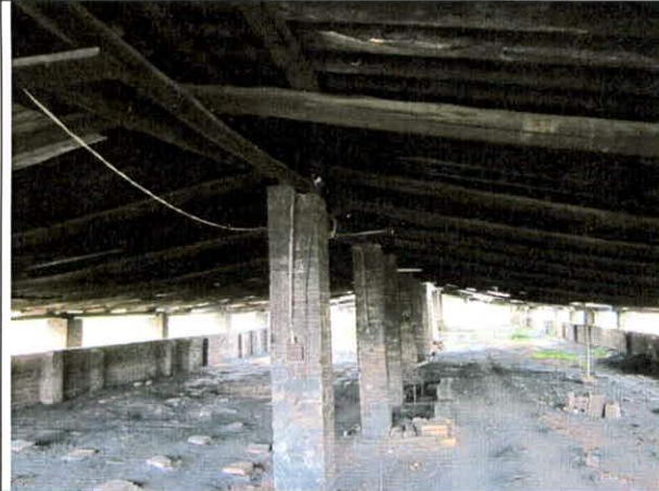
Foto 41. Cubierta en fibrocemento y madera.
