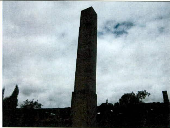
Foto 47. Chimenea en mampostería, horno 2.
