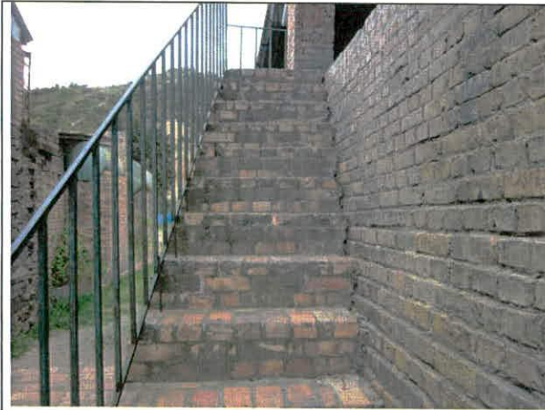
Foto 35. Escaleras sin evidencia de daño, deterioro.
