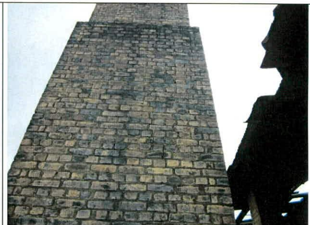
Foto 48. No se detectan daños en la chimenea del horno 2.
