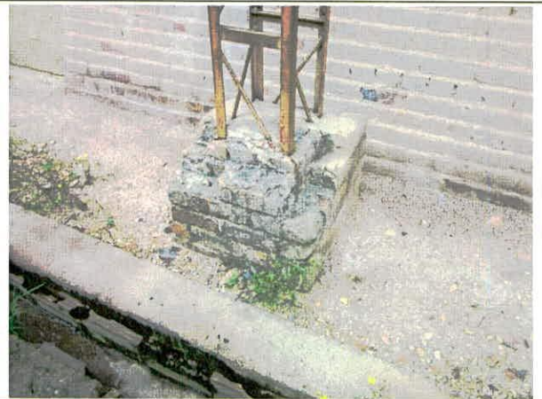
Foto 12. Pedestales de apoyo de las columnas.
