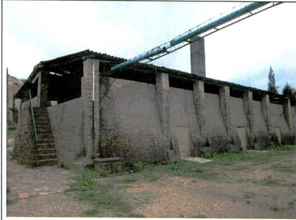
Foto 23. Aspecto externo del Horno 2.
