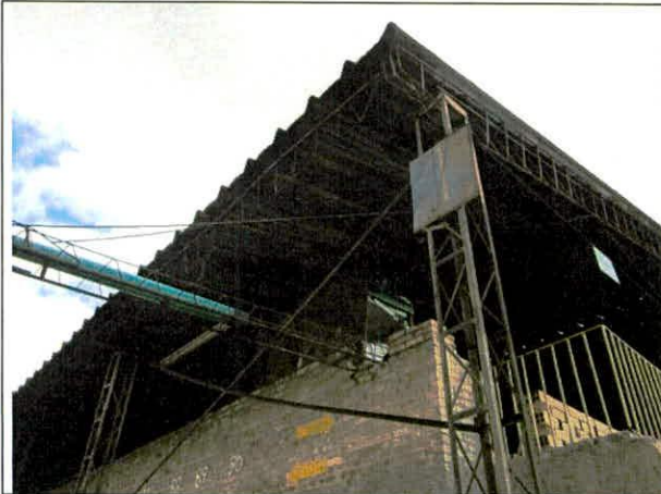
Foto 11. Estructura de cubierta elementos en celosía.
