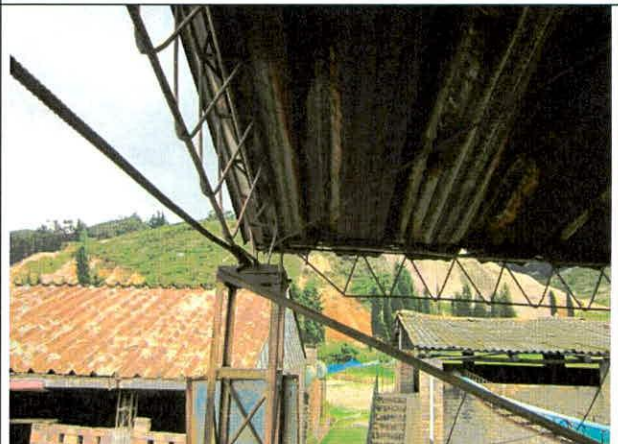
Foto 20. Apoyo de vigas en columnas.
