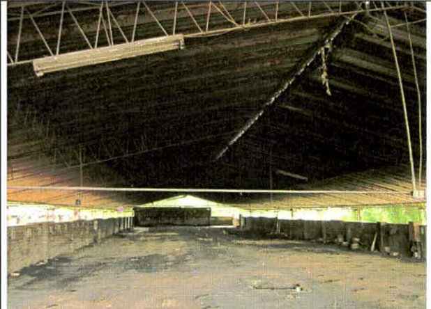
Foto 18. Cubierta de canaletas metálicas.
