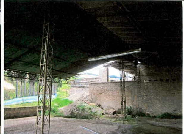
Foto 2. Vista general del interior de la edificación.
