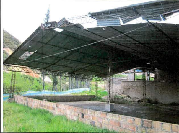
Foto 1. Aspecto externo de la edificación del concepto.
